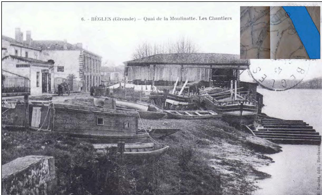
**Fig. 22** : Les chantiers de constructions navales Barthe, quai de la Moulinatte. Devant l’atelier en planche, la photo montre une gabare en construction sur un gril de carénage. En arrière, au bord de la route, le café-tabacs, épicerie, charcuterie et mercerie (!) tenu par la même famille d’après CLEMENS (J.), *Bègles. Mémoire en images*, ouvr. cité, p. 45.
