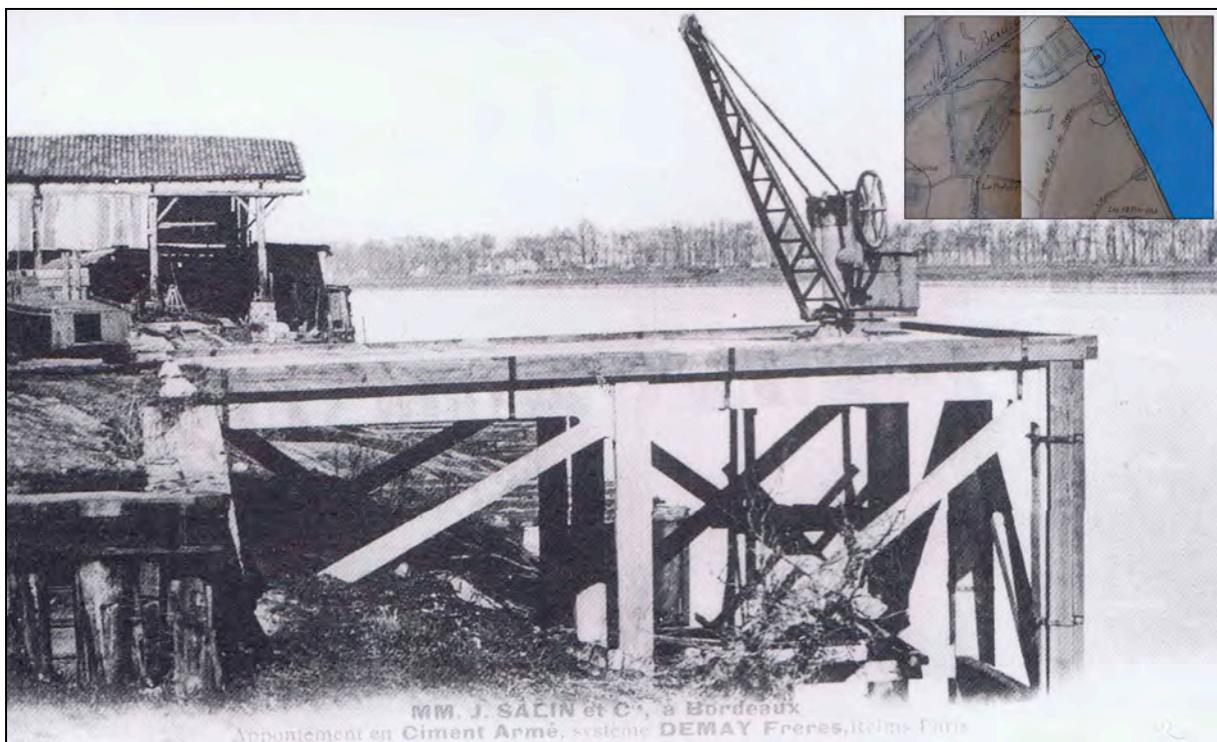
Fig. 24 : L’appontement en ciment armé des chais P. Salin, à l’embouchure de la Moulinatte (en arrière les établissements de constructions navales Barthe, cf. fig. 22), d’après CLEMENS (J.), *Bègles. Mémoire en images*, ouvr. cité, p. 48.
