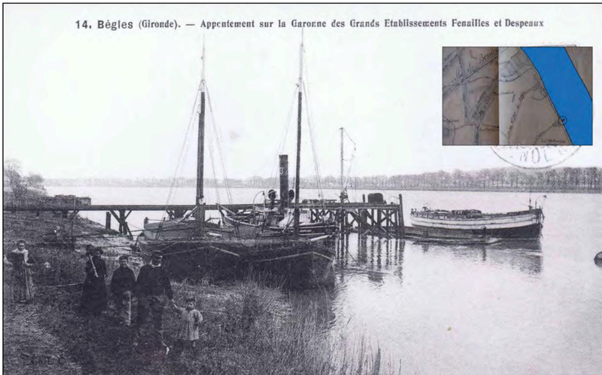
Fig. 25 : L'appontement du Petit Port construit par les établissements Fenailles afin de permettre l'acheminement, par pipe-line, du pétrole depuis les gabares citernes qui y accostent, d'après CLEMENS (J.), *Bègles. Mémoire en images*, ouvr. cité, p. 49.
