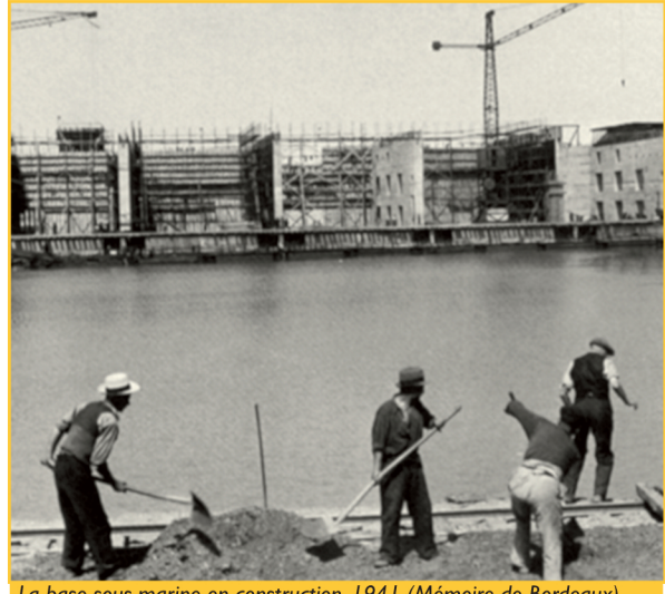
La base sous-marine en construction, 1941 (Mémoire de Bordeaux).
