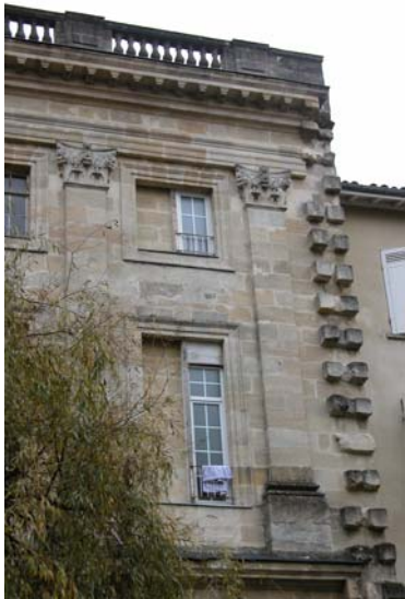
secteur sainte-eulalie-16 Façade arrière de la maison de Secondat, 19 rue Paul-Louis-Lande ; pavillon, en fond de jardin, détail de la rampe d'escalier (Clichés Recensement)
