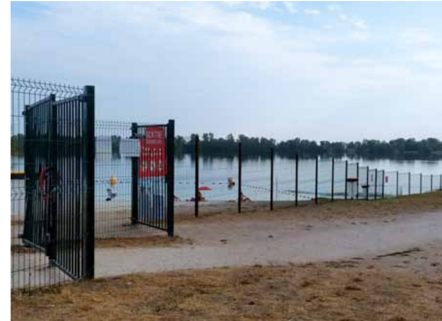
▲ BARRIÈRES ET PORTILLONS INSTALLÉES À L'OCCASION DE LA PANDÉMIE DE COVID19
