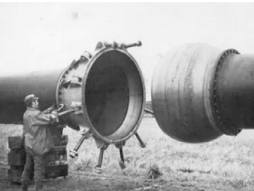
▲ ASSEMBLAGE D'UNE ROTULE ► CONSTRUCTION DU COLLECTEUR
