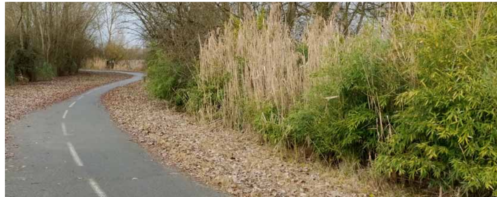
▲ VOIE EXPRESS REVE N°12 SUR LA PRESQU'ÎLE QUI SERT EN MÊME TEMPS DE CHEMINEMENT PIÉTON
