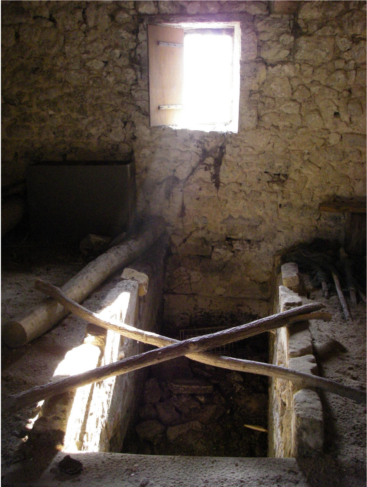
Emplacement de la roue horizontale par en-dessous (disparue), 2013 (cl. Fabrice Demarty, Bordeaux Métropole)
