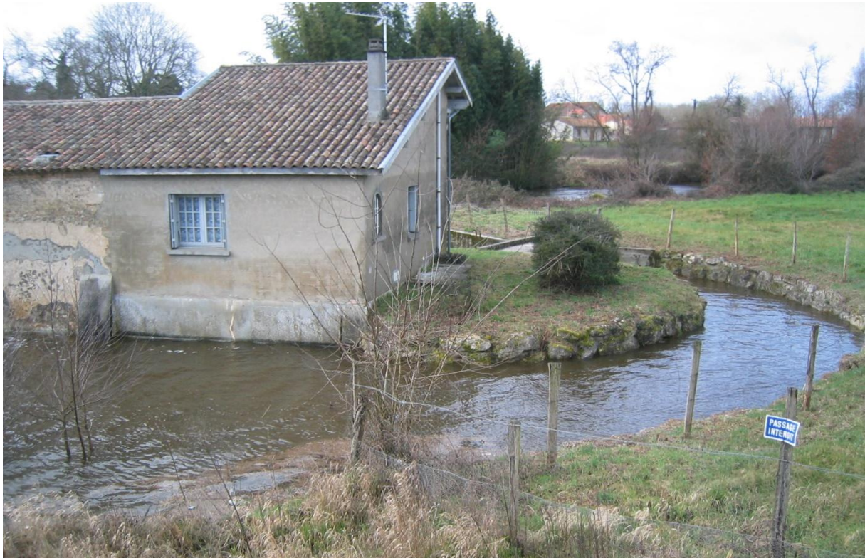
Vue du bras de décharge passant au nord des bâtiments lors de la crue de mars 2006 (cl. Fabrice Demarty)
