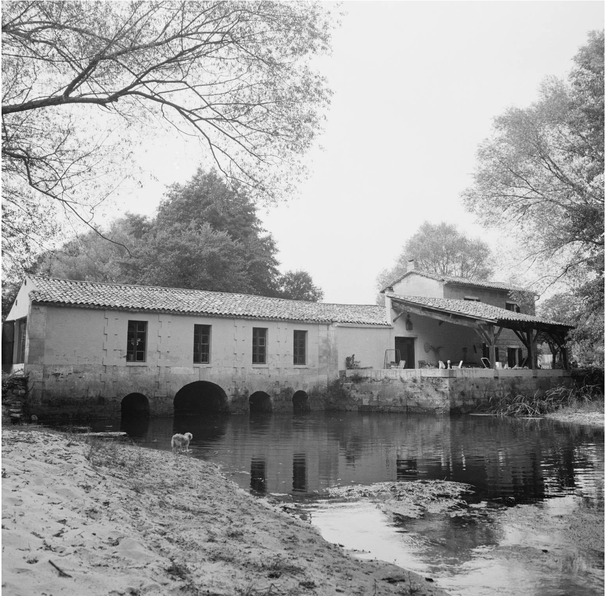
Vue d'ensemble depuis l'aval en 1977 (cl. SRI, IVR72_19773301735X)
