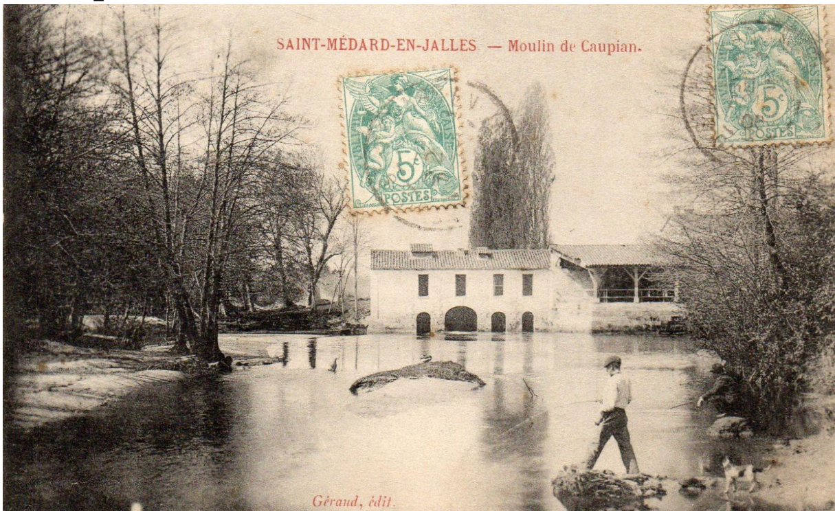
Carte postale montrant le moulin et ses modifications de toit, vue depuis l'aval, vers 1900 (coll. particulière)
