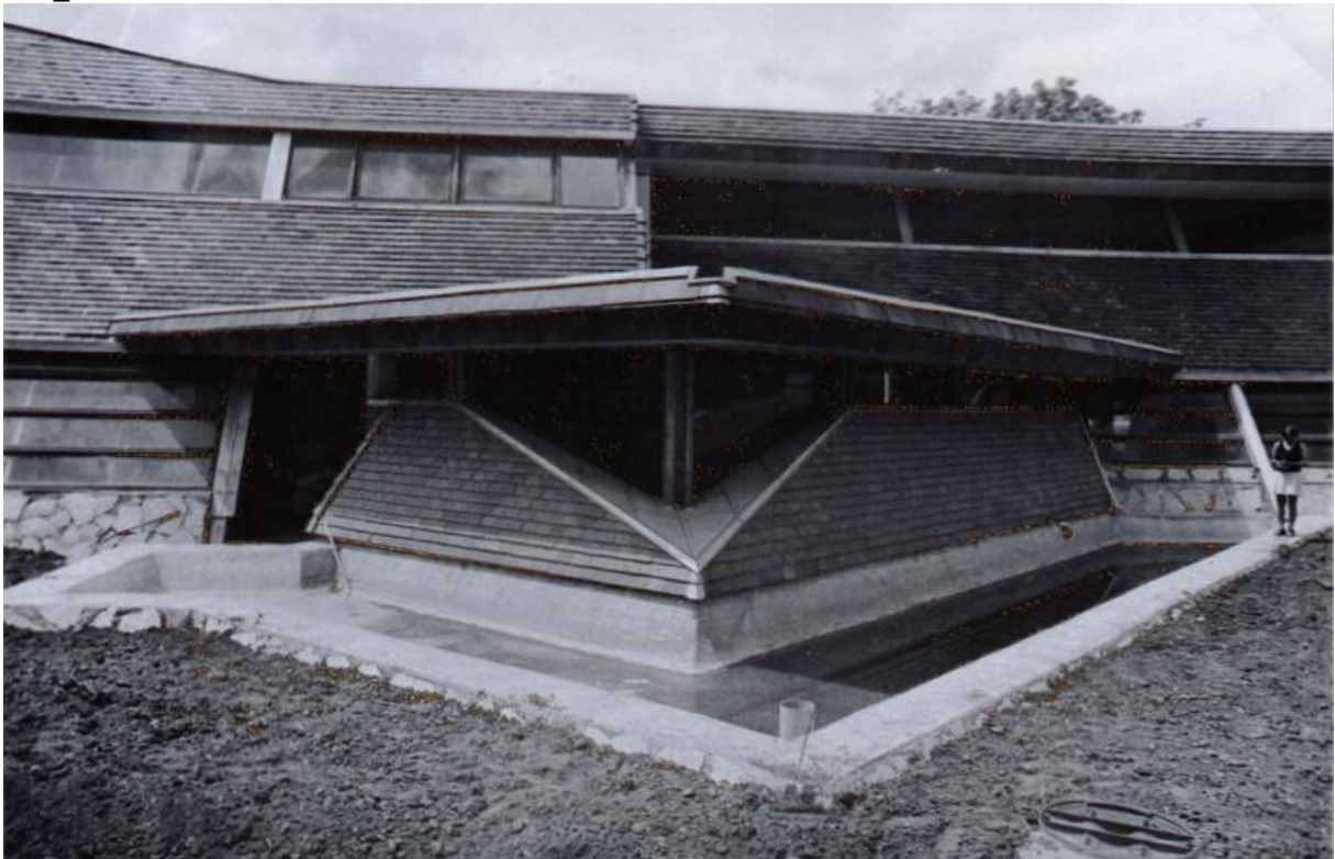
Partie triangulaire à l'est couvrant un dépôt et un bureau, photographie vers 1980 (archives documentaires de l'IRTS)
