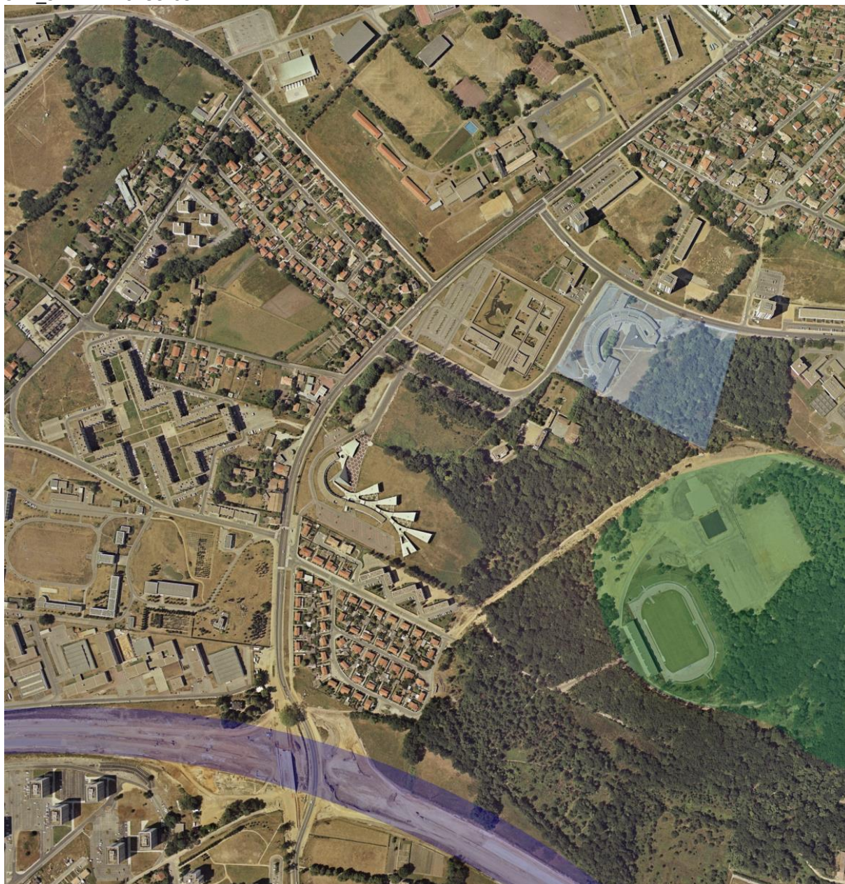
1976 : en bleu clair l'IRTS achevé, en vert l'aménagement de la plaine des sports de Thouars, en violet le chantier de la rocade (dessin F. Grollimund, IGN)
