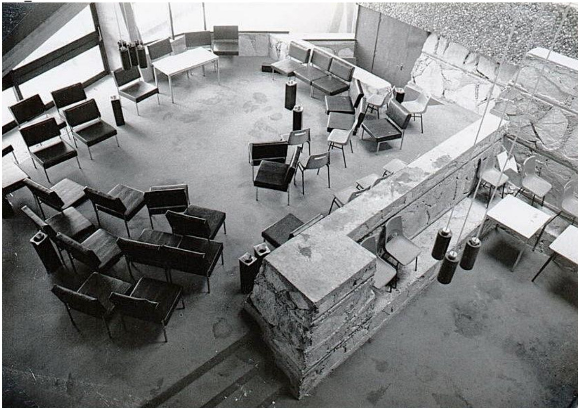
Espace de rencontres dans le bâtiment du foyer avec les murs en moellons banchés, photographie vers 1980 (archives documentaires de l'IRTS)
