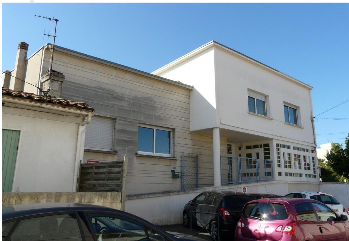
La façade principale de la crèche côté nord en 2017 (cl. A. Peulet)
