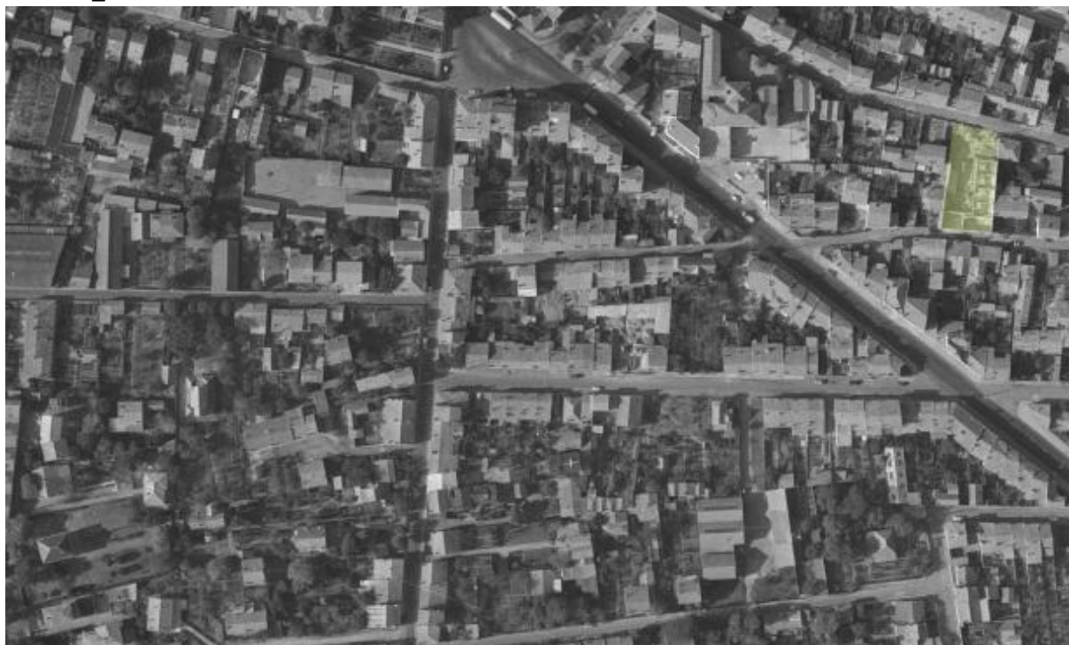
La crèche en cours de construction sur la vue aérienne de 1961 (IGN ; dessin F. Grollimund)
